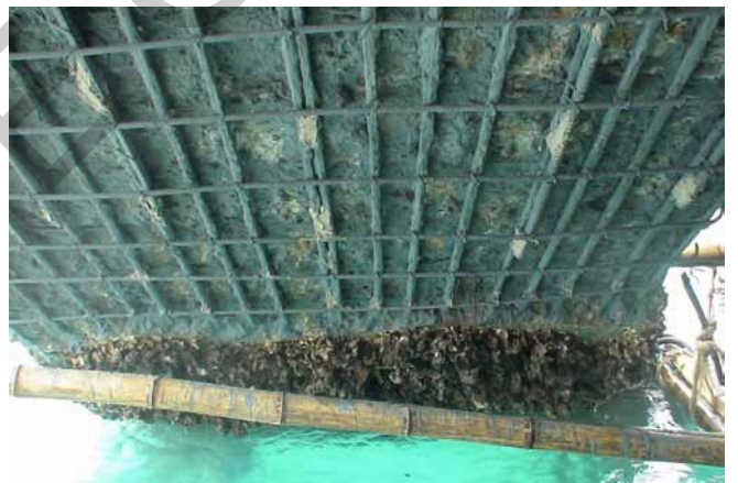
ทำการเปลี่ยนในส่วนที่เสียพื้นที่หน้าตัดเกิน 15 % และขัดสนิมเหล็กเสริมพร้อมเคลือบน้ำยากันสนิมเหล็ก
