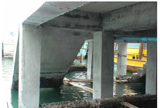
สภาพเสา คาน และท้องพื้นบันไดหลังจากทำการซ่อมแซมเสร็จเรียบร้อยแล้ว
